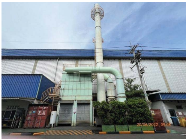
ภาพที่ 5 ปล่องระบบดักฝุ่นจากขั้นตอน Pouring line (BH5)
