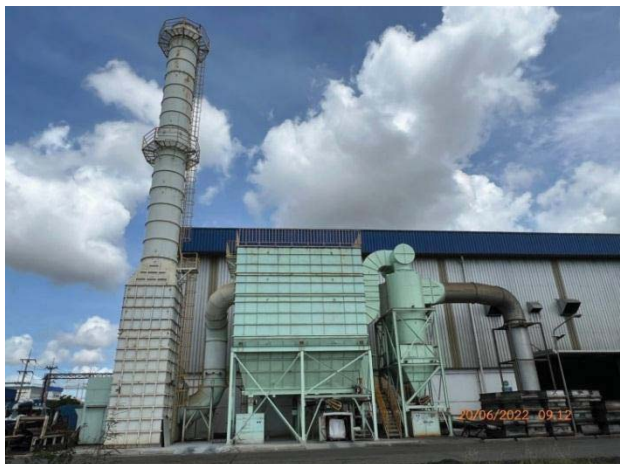
ภาพที่ 1 ปล่องระบบดักฝุ่นจาก Melting furnace (BH1)
